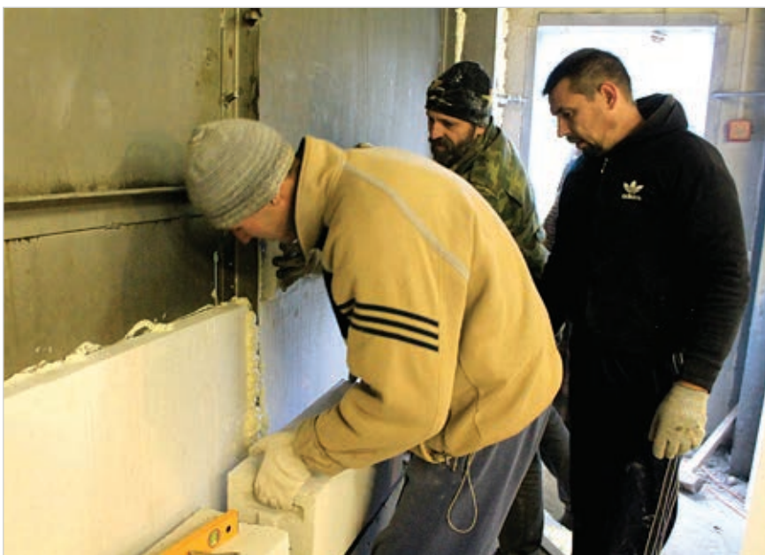
Ремонтные работы во временном храме осуществляются силами прихожан. Ноябрь 2013 года
